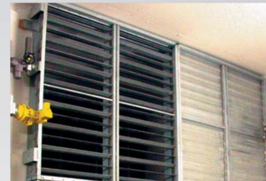
HID - ByPass - Klappe für Abluftfilteranlage
